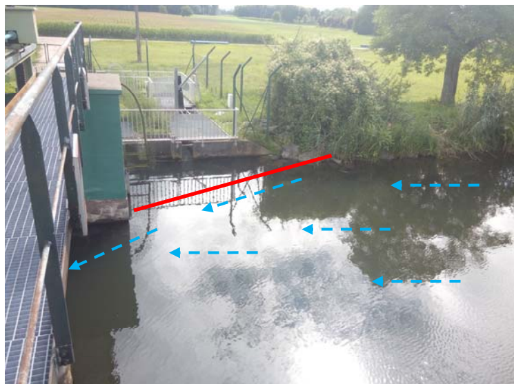
Figure 3 : Positionnement et schéma de principe d'un déflecteur de surface
